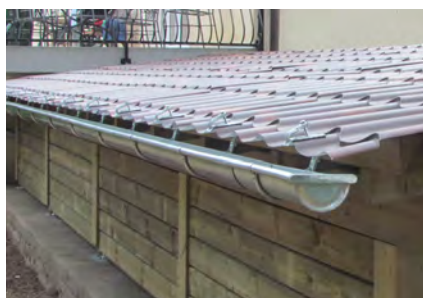
Gouttière en acier galvanisé
